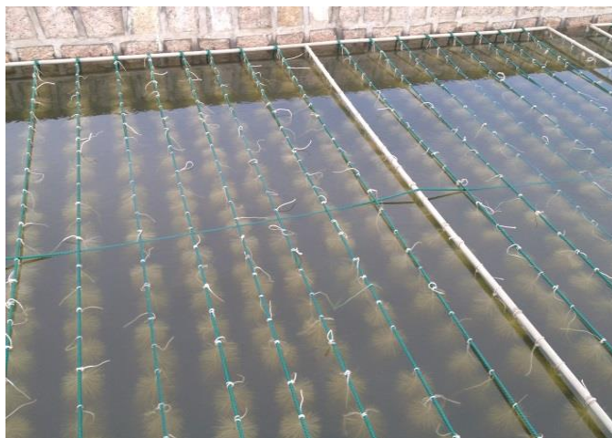
图 3. 截污生物净化池
